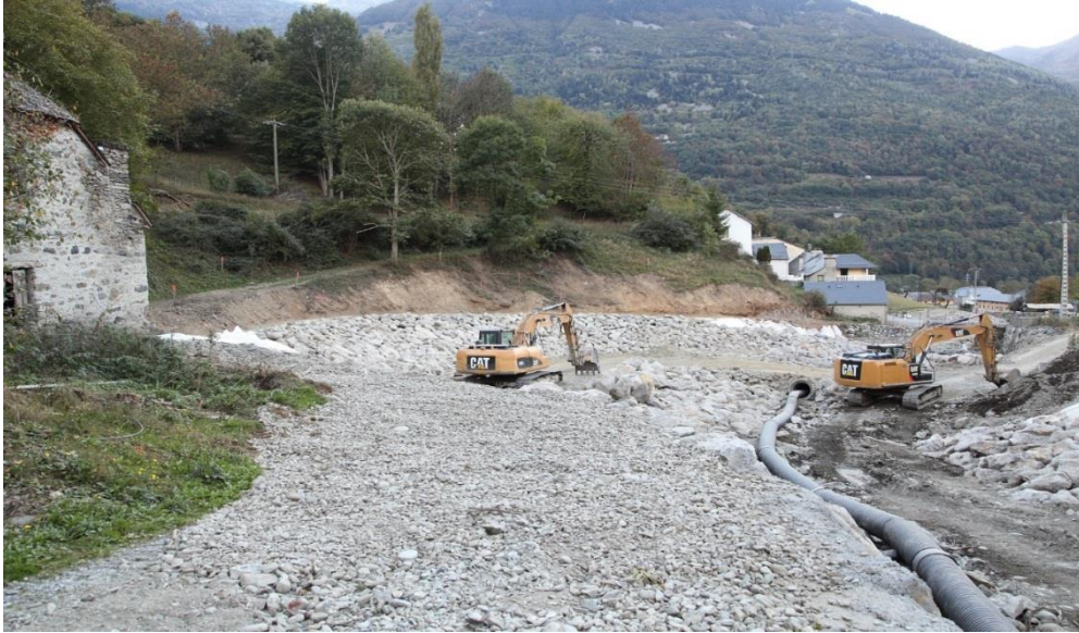
Création d'une plage de dépôt sur le torrent de l'Yse en amont du pont de l'Egalité
